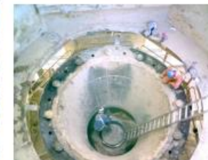
CAMBIO DE CONCAVAS CH. PRIMARIO (FUND. BLANCA ALTOCROMO)
